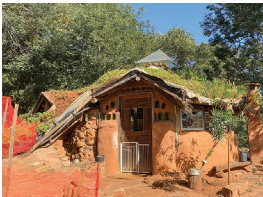
Os alunos visitaram lugares em que havia exemplos de bioconstrução, como a casa de taipa de pilão presente em uma antiga fazenda de café
